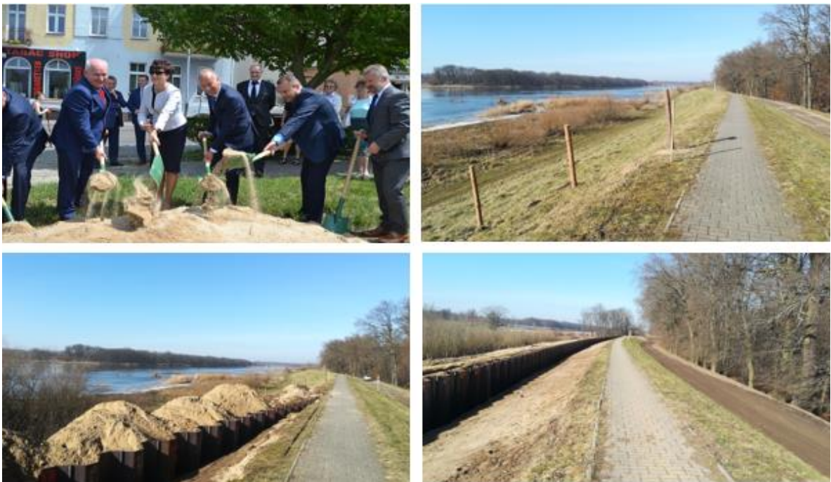
Rysunek 23. Zdjęcia z rozpoczęcia i realizacji prac
